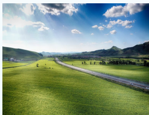
张承高速公路工程
