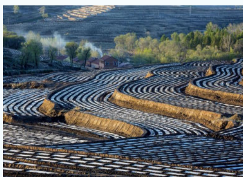
河北省围场县坡耕地水土流失综合治理工程
