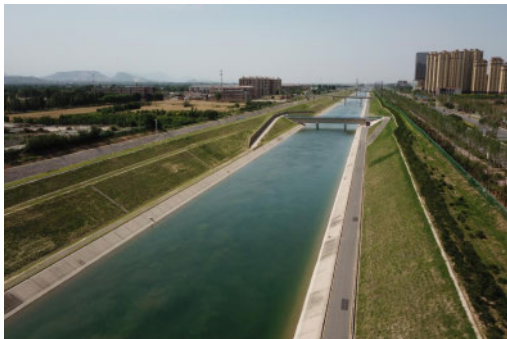
南水北调一期工程水土保持防护
