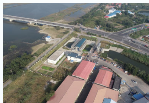
天津市中心城区及环城四区水系联通工程青排渠、北丰河连通工程
