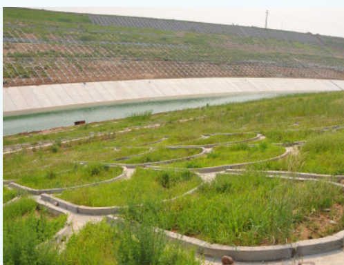
南水北调中线干线工程
