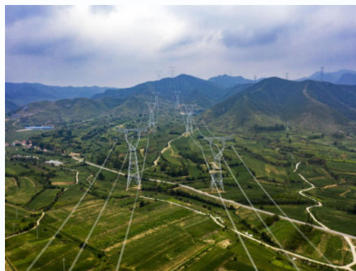
张北~雄安 1000 千伏特高压交流输电工程
