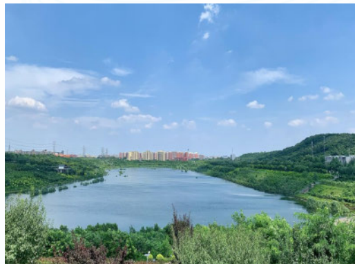
北京市西郊雨洪调蓄工程
