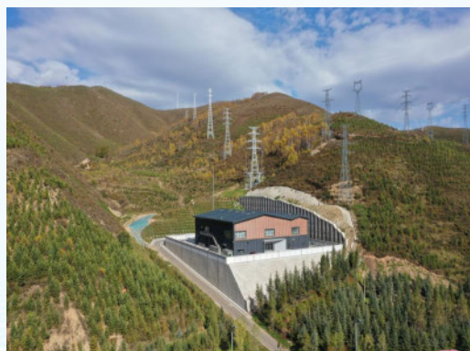
保障北京冬奥绿色电能电力组团工程
