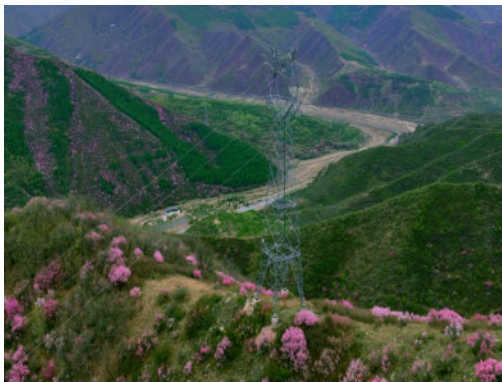
北京冬奥会张家口赛区配套电力工程项目群
