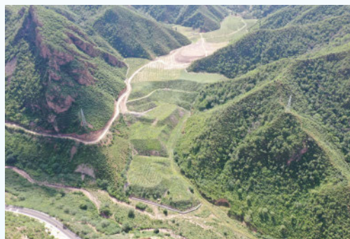
河北省丰宁抽水蓄能电站东沟渣场复绿
