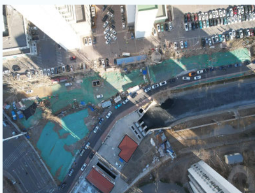
天津市南水北调中线市内配套工程西河 泵站至凌庄水厂红旗路线 DN2200 原水 管道重建工程
