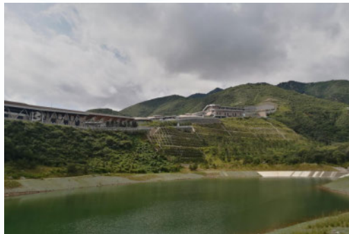
国家雪车雪橇中心边坡防护措施
