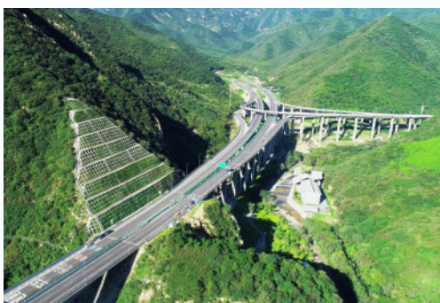
北京市延崇高速九级护坡
