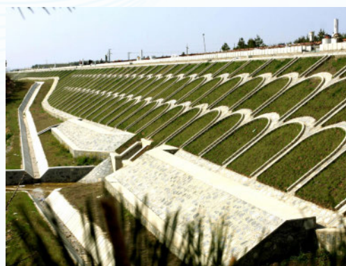
京沪高速铁路工程
