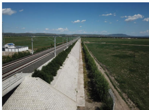
张家口至呼和浩特铁路工程
